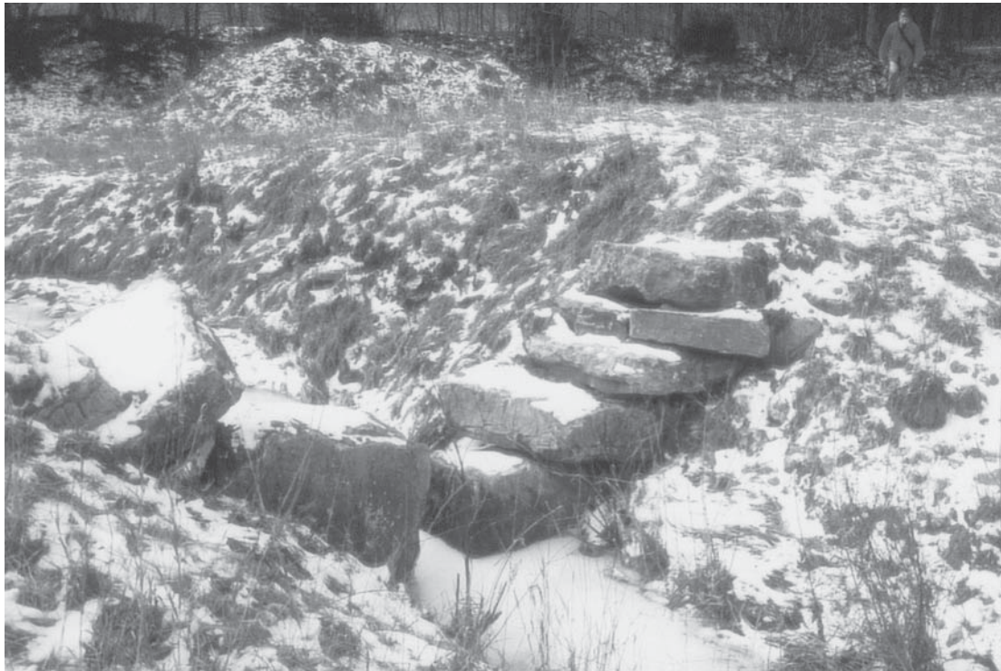
Abb. 3: Bruchsteindrossel am Berolzheimer Graben
