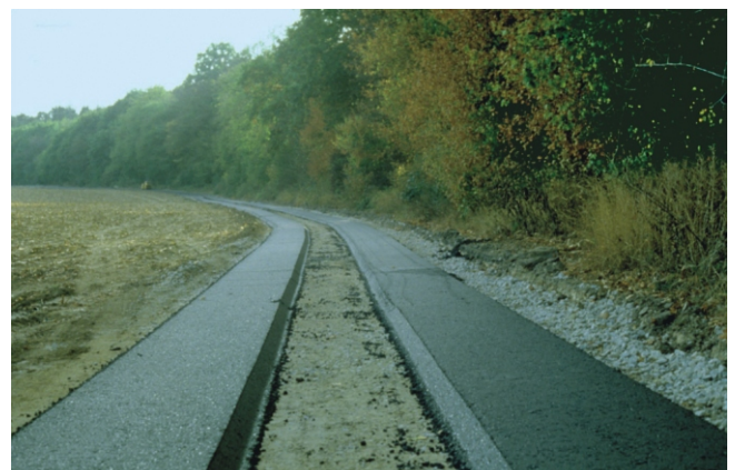
Bild 4: Asphalt-Spurweg in der Bauphase
