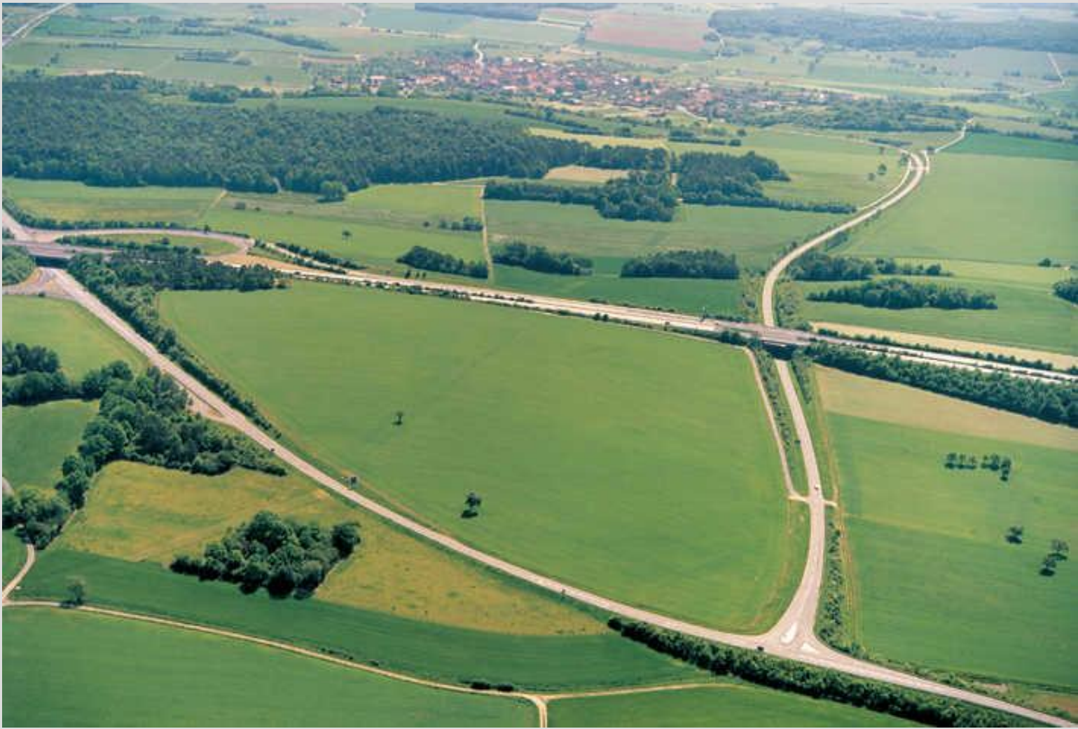
Umsetzung einer Großbaumaßnahme mit Unternehmensflurneuordnung
