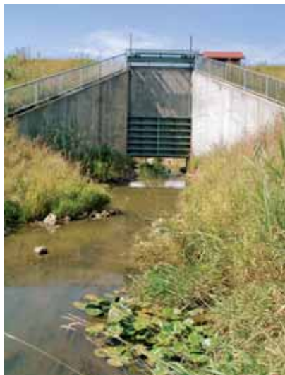
Durchlassbauwerk am Rückhaltebecken Oberdorf
