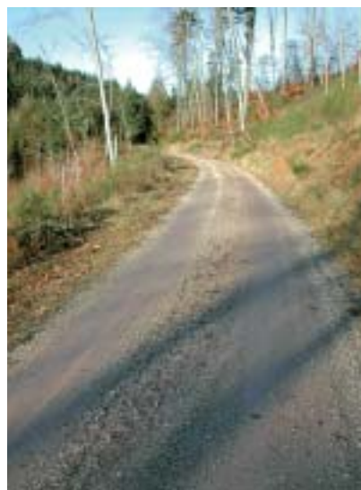
Waldweg nach der Instandsetzung
