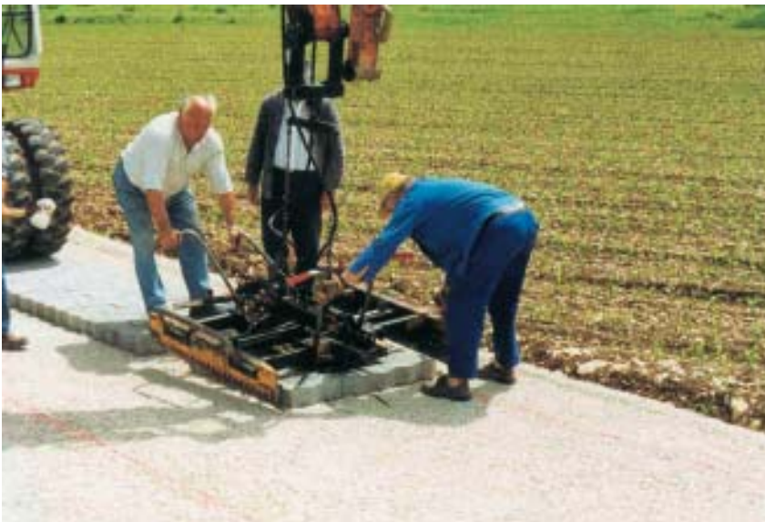
Arbeiten mit der Verlegezange
