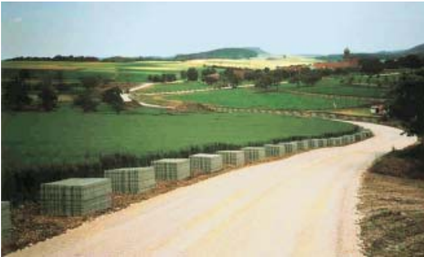
Anlieferung der Pflastersteine
