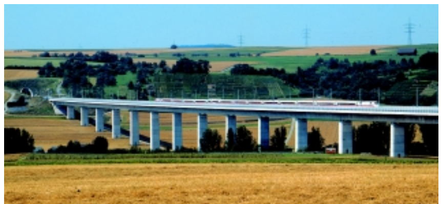
Neubaustrecke Mannheim – Stuttgart (Enztalviadukt)
