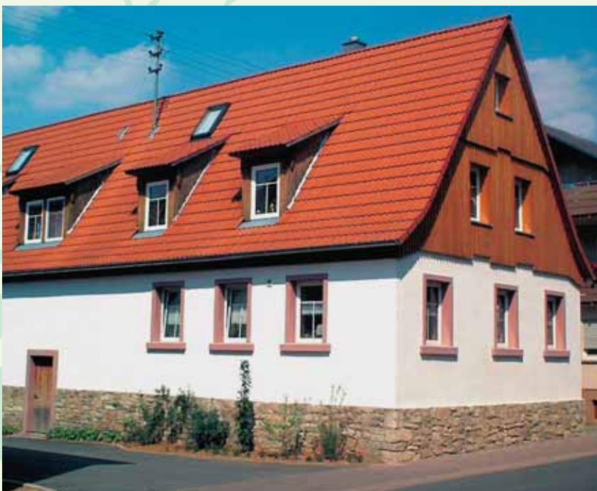
Modernisierung (ehemaliges Förderprogramm Dorfentwicklung)
