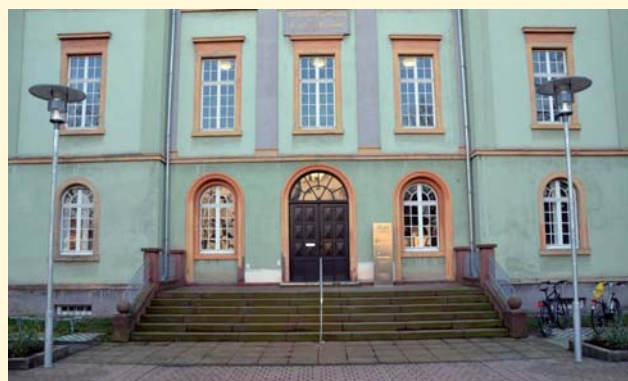
Eingang zum Dienstgebäude in Karlsruhe
