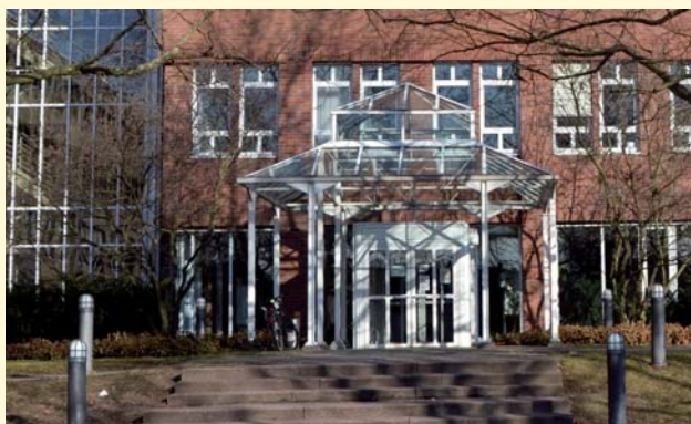
Eingang zum Dienstgebäude in Kornwestheim
